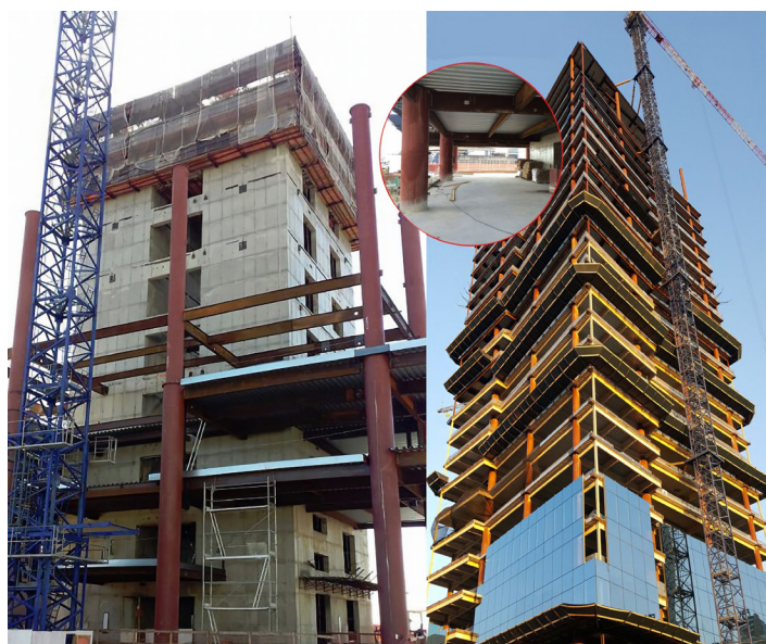
Edifício Concórdia Corporate Nova Lima - MG
