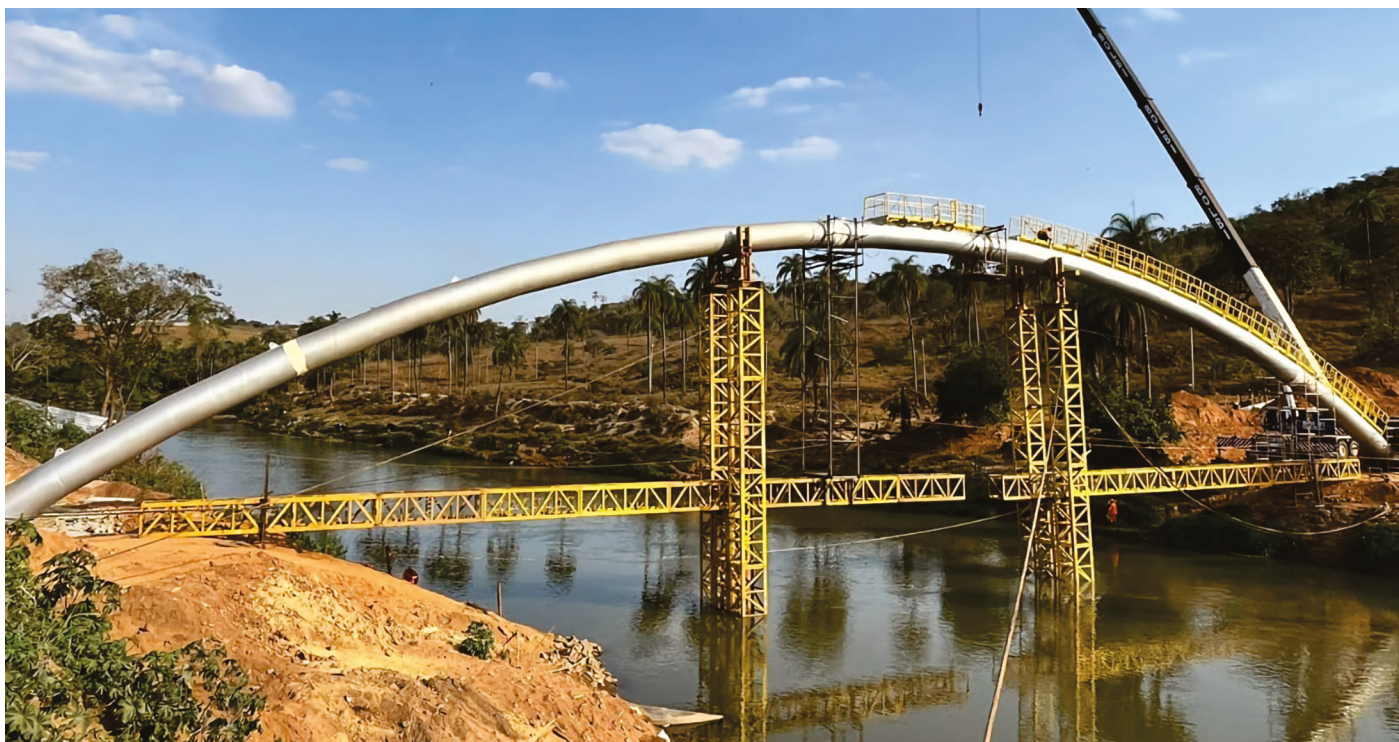
Travessia sobre Rio Paraopeba - Betim - MG
