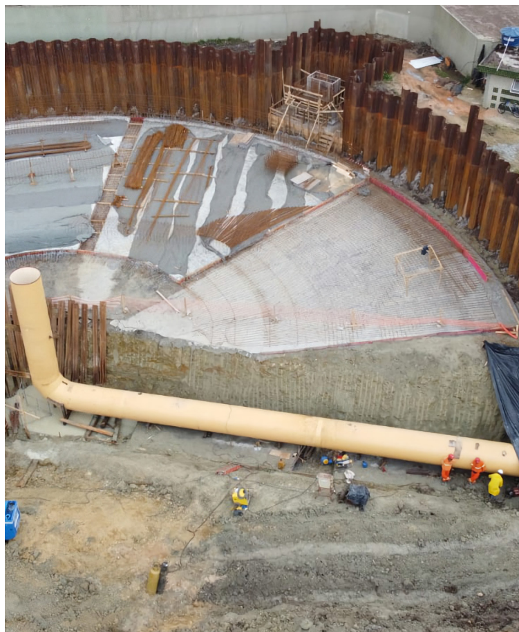
ETE Atuba Sul - Curitiba - PR
