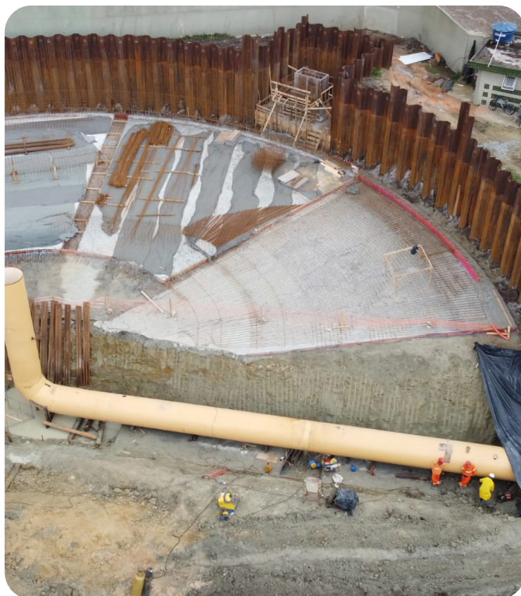
ETE Atuba Sul - Curitiba - PR
