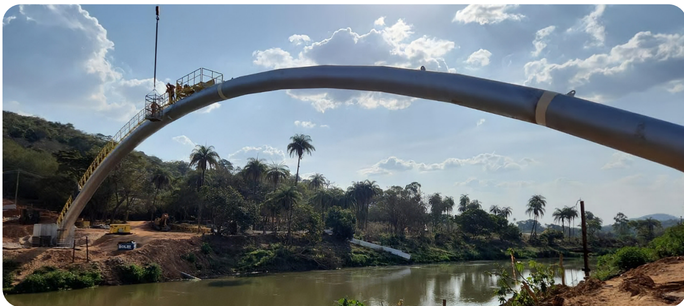
Travessia sobre Rio Paraopeba - Betim - MG
