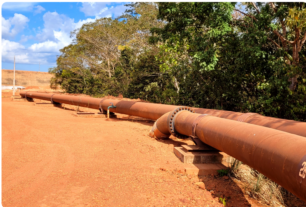
Tubos SteelMast aplicados em Adutora e Linha de Rejeito – Cliente MRN – Oriximiná/PA
